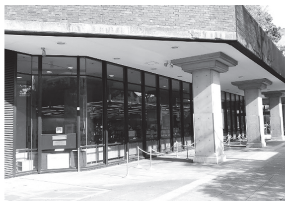
写真8 同じく鬼頭氏が手掛けた神戸市立中央図書館（当館のような窓・コンクリートに、煉瓦が加わった例）
