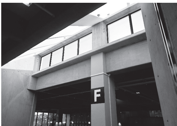
写真9 館内各所にある天窓
