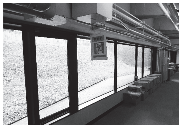
写真11 地下1階西側窓 地下書庫まで光を入れたかったのだから
