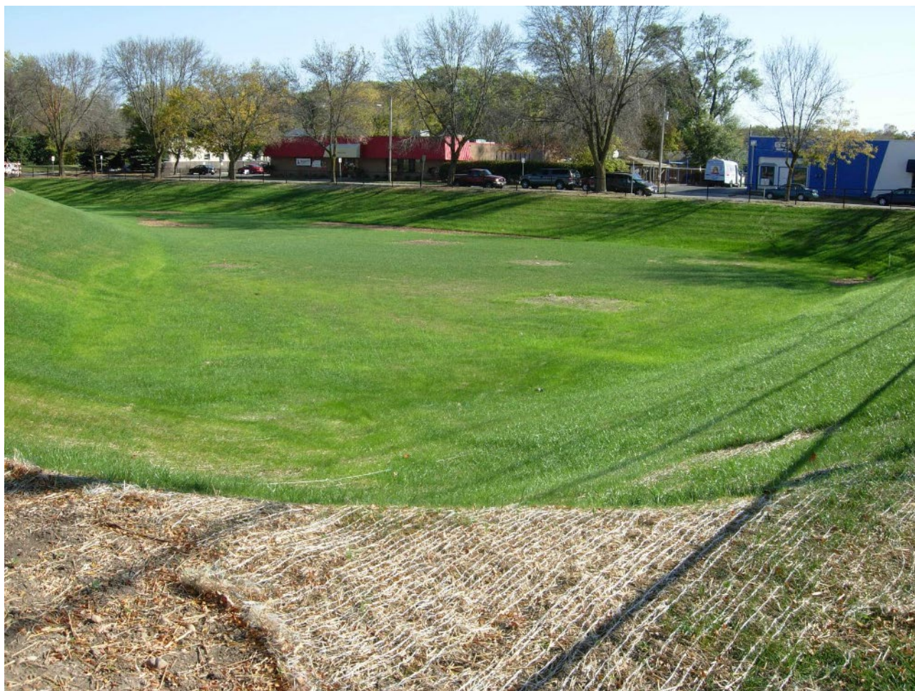
Figura 5: Dry detention basin in Grandview Park, Waukesha, Wisconsin. Foto di ottobre 2010. Fonte: Aaron Volkening [CC BY 2.0]. Da Flickr.com
