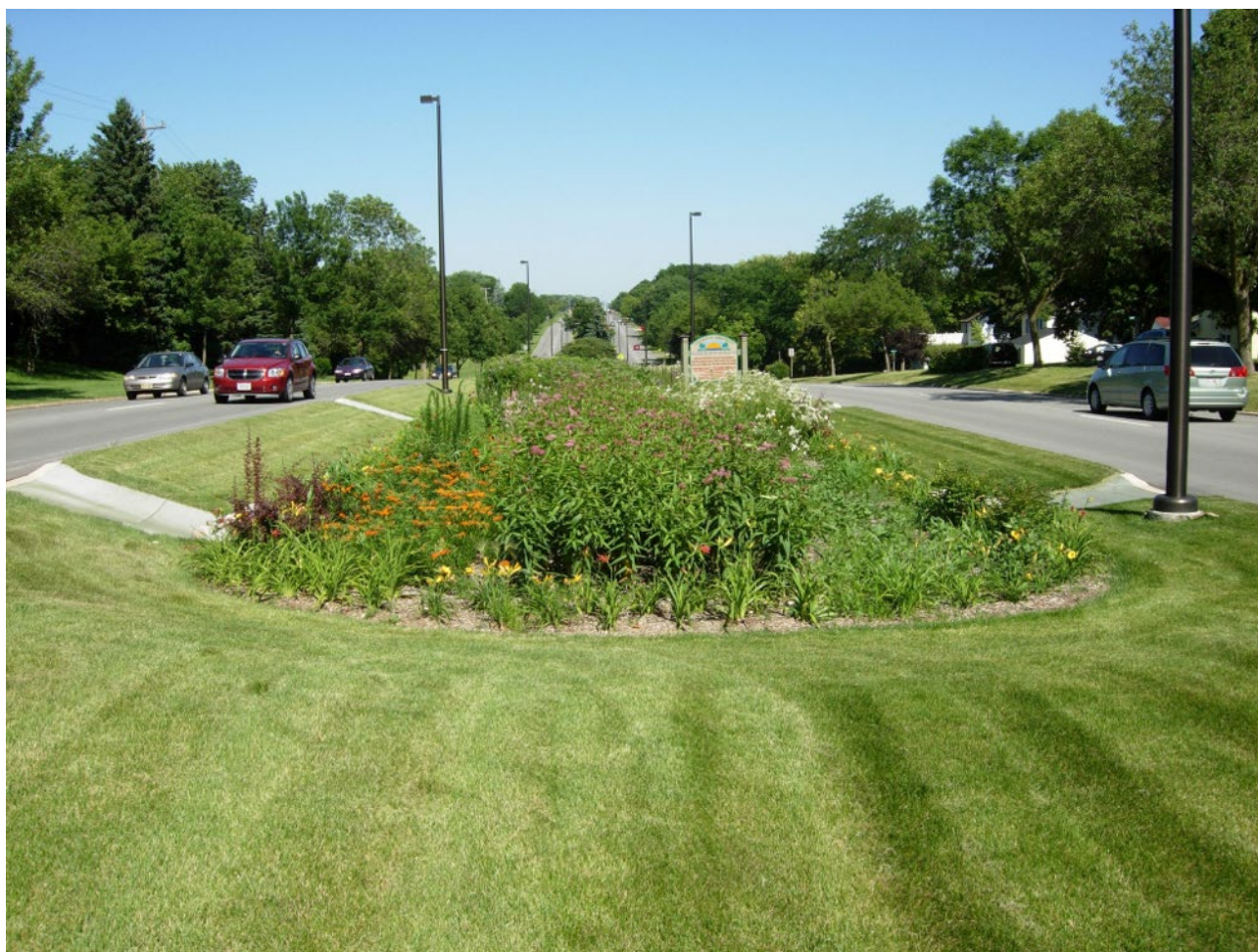
Figura 4: Bioretention / sideswale nel mezzo di Grange Avenue a Greendale, Wisconsin. Foto di luglio 2010. Fonte: Aaron Volkening [CC BY 2.0]. Da Flickr.com
