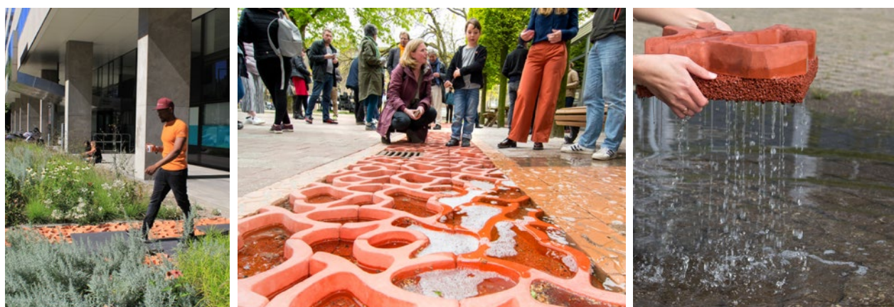
Figura 1: Rain(a)Way Katshoek Garden in Rotterdam. Il pavimento "Flood Permeable", è composto da due diversi tipi di calcestruzzo. Lo strato inferiore in calcestruzzo drenante consente all'acqua piovana di filtrare lentamente nel terreno, mentre le vaschette dello strato superiore accumulano acqua permettendo agli utenti di poter camminare liberamente. Fonte: Rain(a)Way
