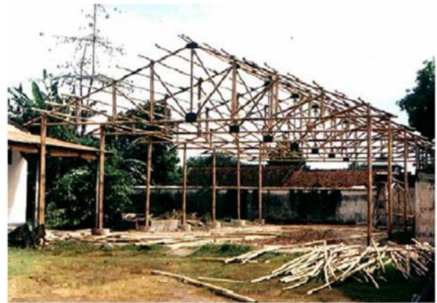
Gambar 5. Konstruksi kuda-kuda Bambu (Sumber: Morisco, 1999)
