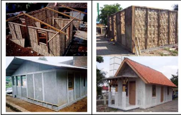
Gambar 7. Rumah dengan dinding bambu plester. (sumber: Tanuwidjaja et al , 2009)
