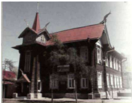
Дом с драконами (ул. Красноармейская, 68)
