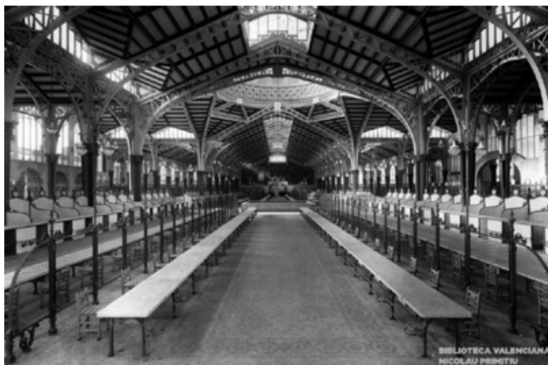
Fig. 1: Interno del Mercato di Valencia qualche giorno prima della sua inaugurazione nel 1928. L'inizio dei lavori risale al 1910.
