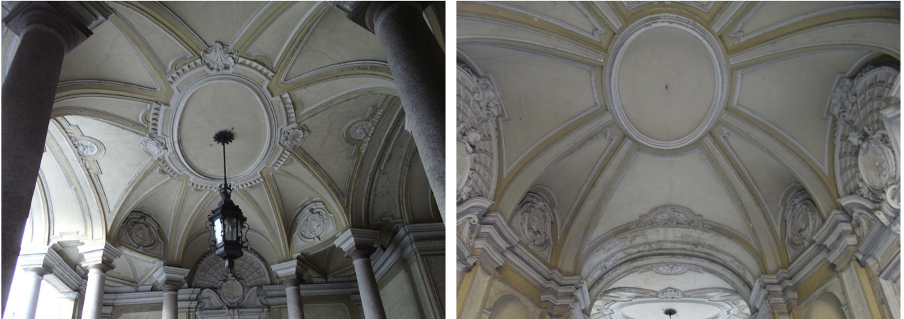
Fig. 11. Elliptic lunettes in the vaults of the atrium and vestibule of Palazzo Provana di Collegno. Photo: Marco Vitali.
