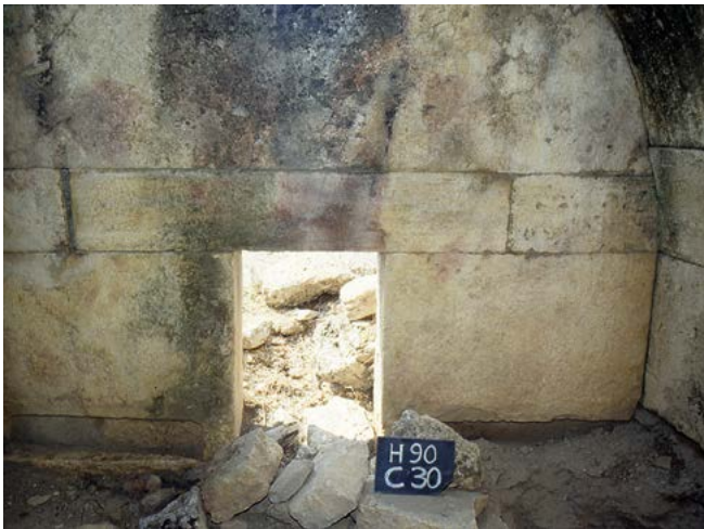
Figura 14. Tumulo C30, interno camera, particolare della lavorazione in curva dell'ultimo corso della muratura per adeguarsi all'appoggio del concio d'imposta della volta, collaborando alla tenuta statica della struttura voltata.
