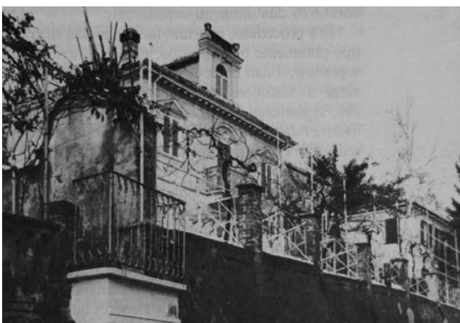
Villino con pergolato e ingresso con balconcino a Cavoretto.
