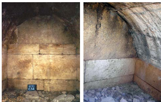
Figura 6 a, b. Tumulo C14, particolare della muratura pseudoisodoma della camera e della lavorazione dell'intradosso della volta.
