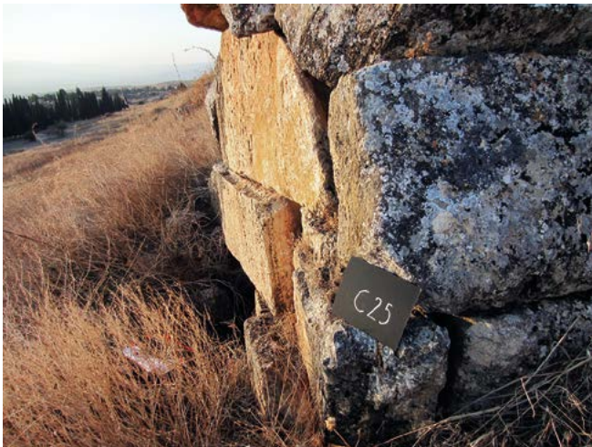
Figura 16 a, b. Tumulo C25, particolare della risega dell'architrave; tumulo C30, particolare dell'architrave con aggetti terminali.
