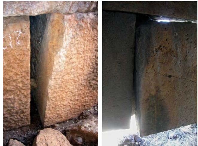
Figura 15 a, b. Tumulo C17, particolare della lavorazione con anathyrosis della faccia di contatto di un blocco di muratura; tumulo C25, in evidenza la giunzione a dente tra architrave e blocco adiacente.
