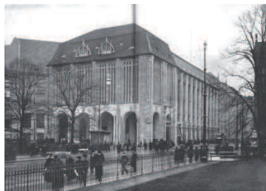
Fig. 13. Warenhaus Wertheim Leipziger Platz (1904/1906), testata sulla piazza.
