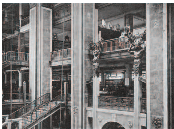
Fig. 21. Corte interna, particolare dei pilastri e del sistema di piani e collegamenti a struttura metallica; opere in bronzo di Georg Wrba.
