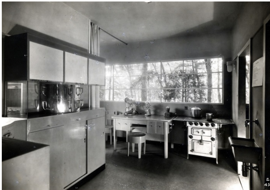
Fig. 5 Cucina Elettrica by P. Bottoni.
