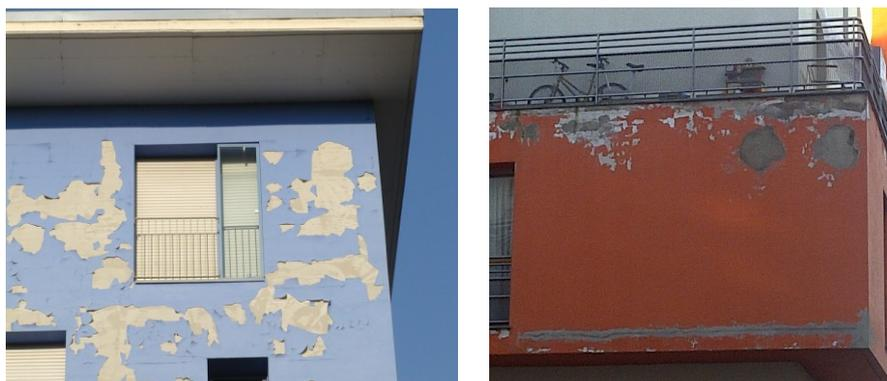
*Fig. 1 - La scarsa qualità costruttiva riscontrabile in edifici residenziale di recente realizzazione determina un immediato bisogno di interventi di manutenzione.*
