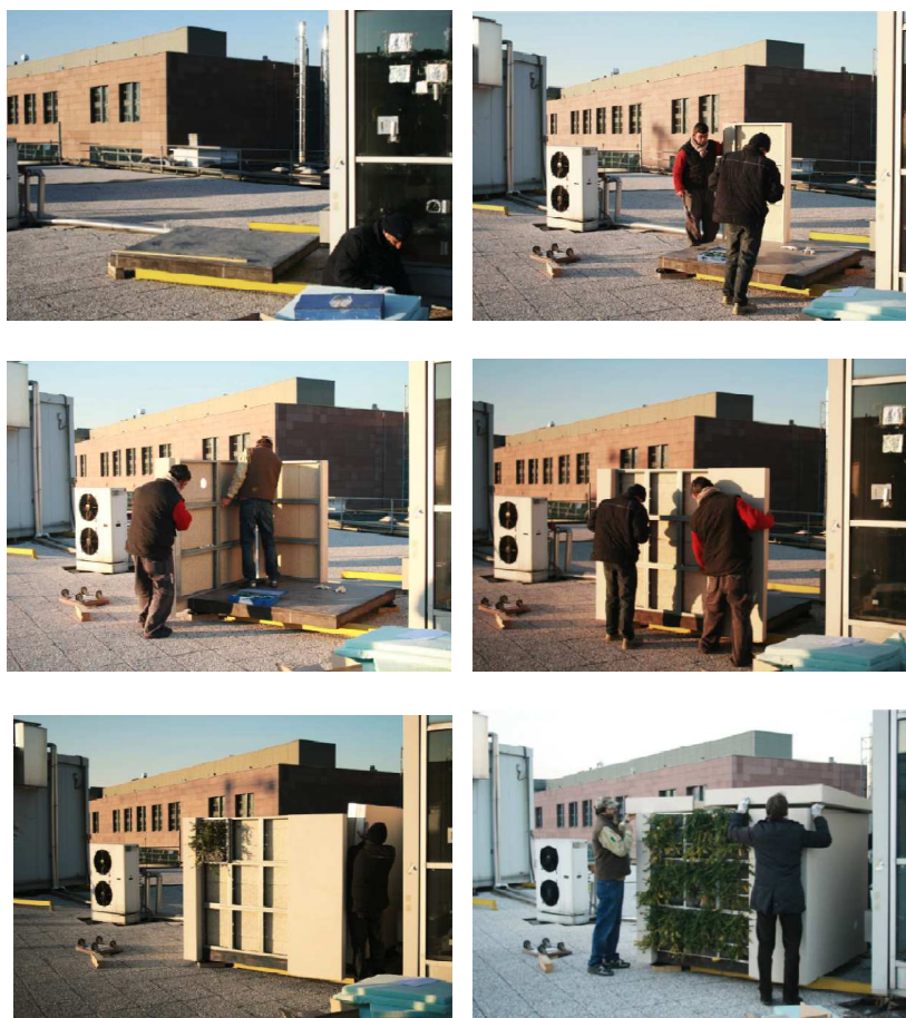
Figura 13 - Fasi di montaggio del dimostratore presso il Dipartimento Energia del Politecnico di Torino.
