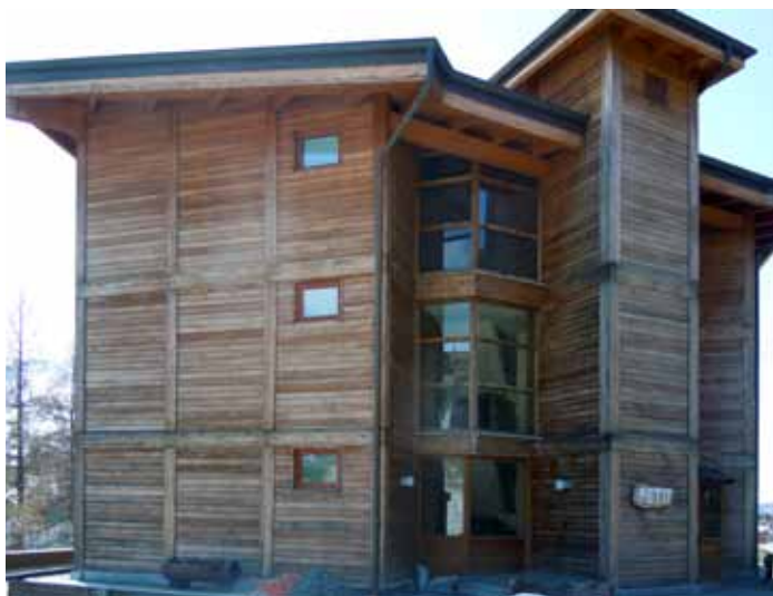
Sestriere. Strato esterno parete in legno (2006): alterazione cromatica.
