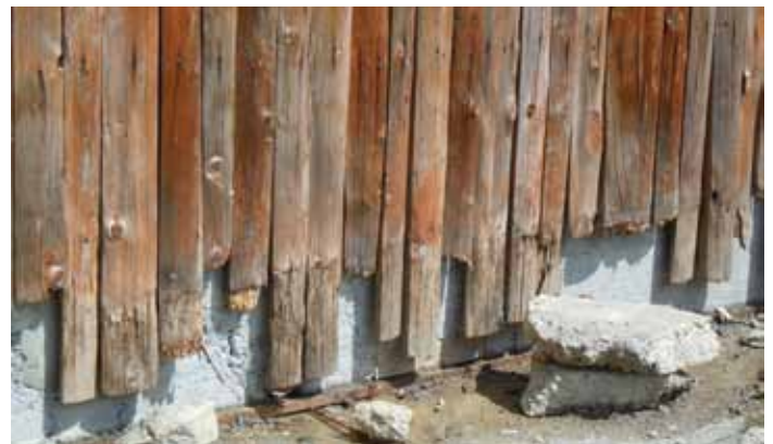
Sestriere. Rivestimenti parietali e cornicione (anni ottanta): alterazione cromatica, sfogliatura, degrado biotico, imbibizione.
