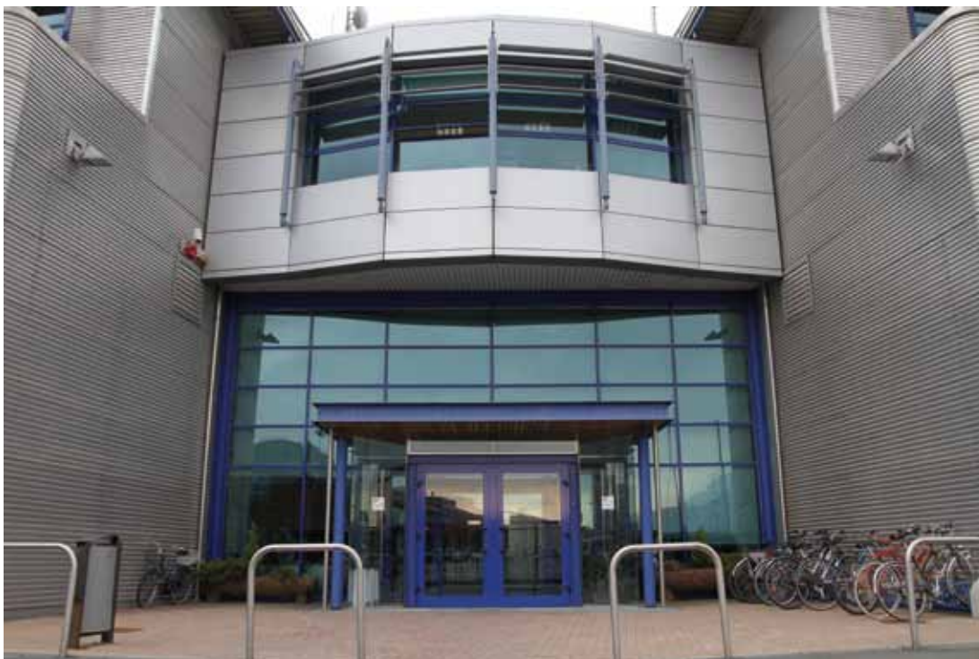
Figura 2.1.11: Pépinière d'Entreprises dell'area industriale Espace Aosta
