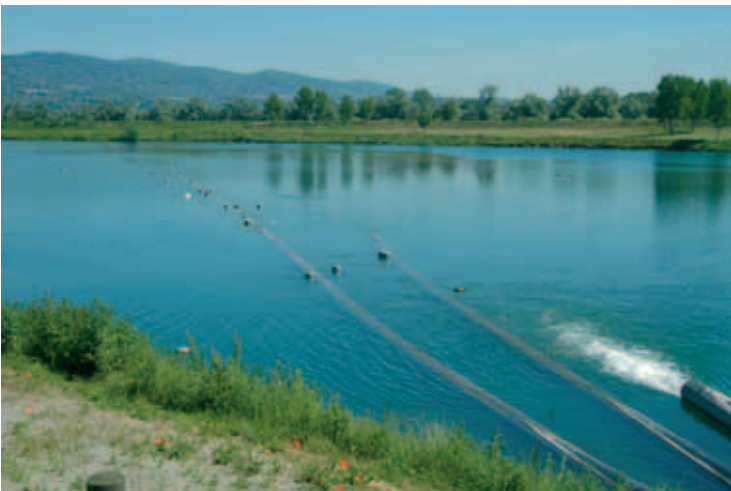
Il bacino di Lagunaggio Smat oggi in esercizio a La Loggia.
