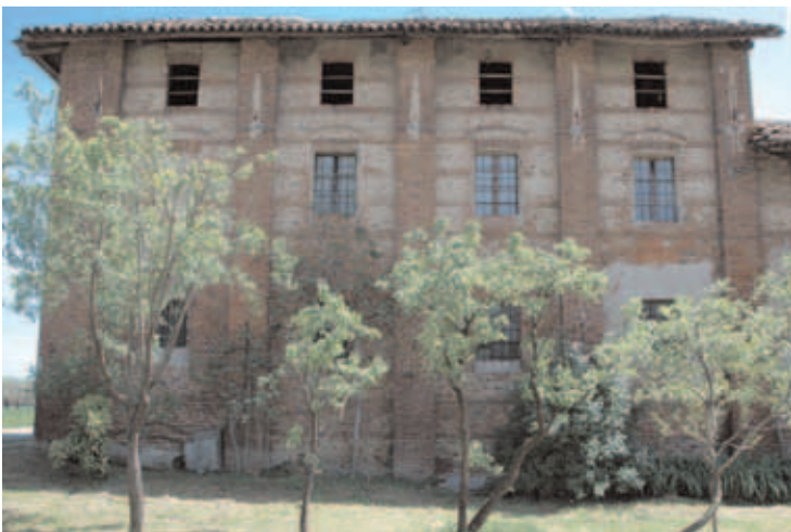
Le caschine del complesso del Poasso a Mezzi Po a Settimo torinese.
