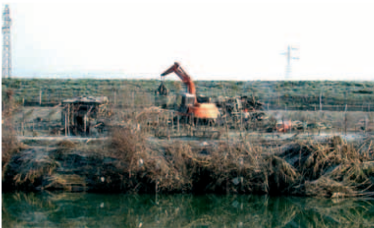
Interventi di demolizione di orti abusivi lungo il fiume.
