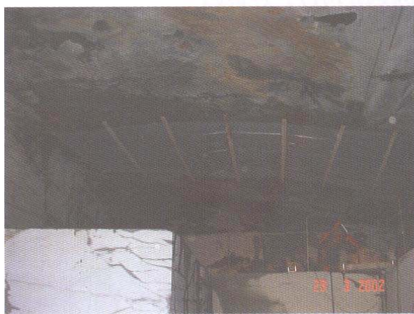
FIG. 9 - Dettaglio della discontinuità naturale che potrebbe originare un falso tetto nella cava. Detail of natural joint that could originate a false roof in the quarry.
