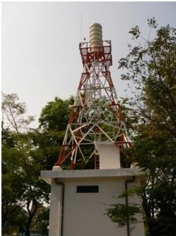
Gambar 4. Sirine peringatan dini yang terpasang di suatu wilayah di Kota Padang (Anwar 2011)
