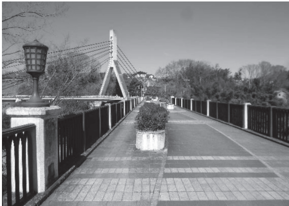
第5図 アニメに描かれた秩父橋と実際の秩父橋
