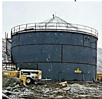
Figura N° 2.16: Techo auto- soportado
