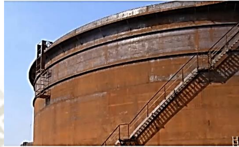
Figura N° 2.52: Anillo superior de viento
