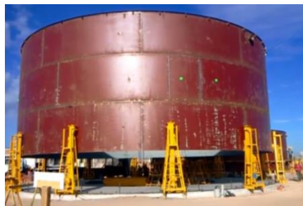
Figura N° 3.7: Gateo de los anillos del tanque
