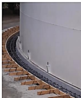
Figura N° 2.46: Distribución de Pernos de anclaje
