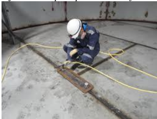
Figura N° 2.71: Caja de vacío para pruebas en el fondo de tanques
