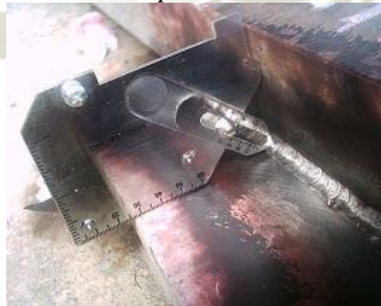
Figura N° 3.10: Inspección de cordón exterior
