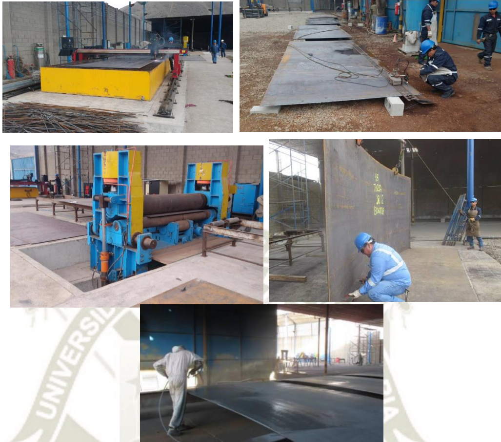
Figura N° 3.5: Trabajos de cuadrado, biselado y rolado
