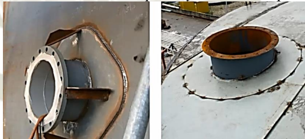
Figura N° 2.37: Conexiones de pared y techo en tanques
