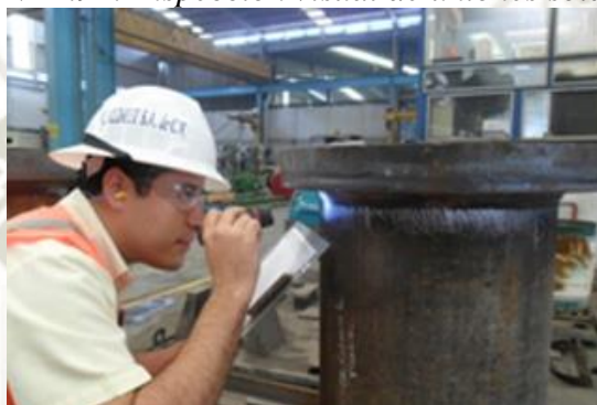
Figura N° 2.91: Inspección visual de uniones soldadas
