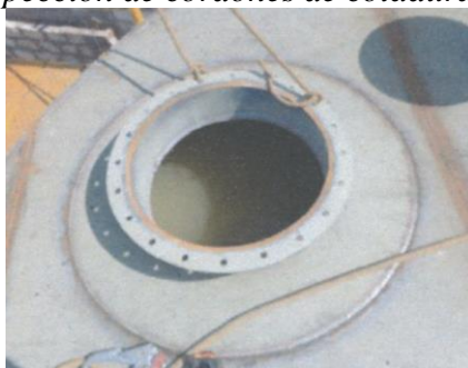
Figura N° 2.74: Inspección de cordones de coladura del casco con agua
