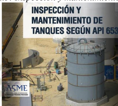
Figura N° 2.3: Inspección y mantenimiento API 653
