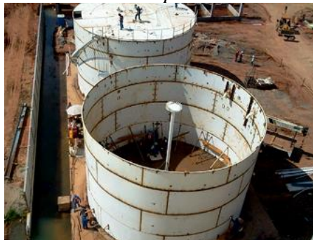
Figura N° 2.27: Pared de tanque de almacenamiento
