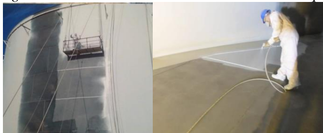
Figura N° 4.4: Pintado exterior e interior del tanque
