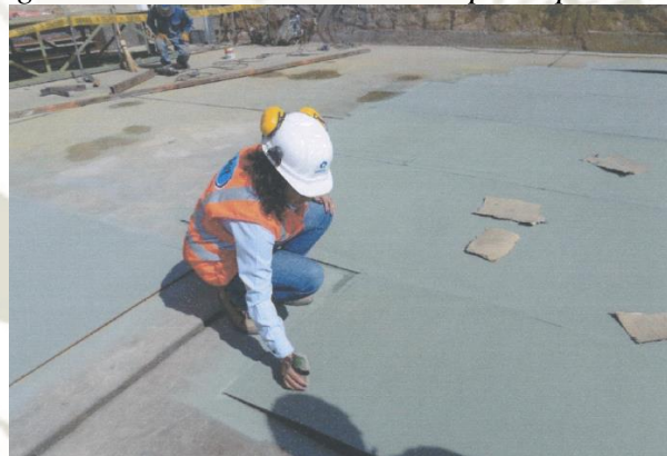
Figura N° 4.3: Medición de la capa de pintura
