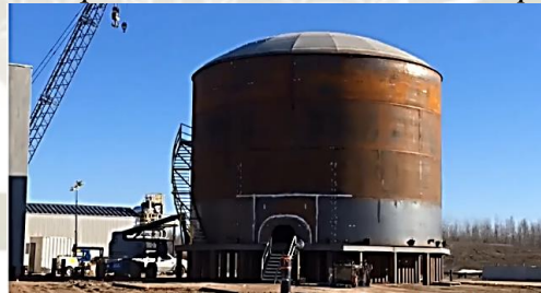
Figura N° 2.12: Tanque de almacenamiento techo tipo sombrilla
