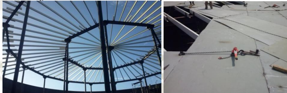
Figura N° 3.8: Estructura de soporte del techo
