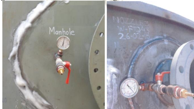
Figura N° 3.16: Pruebas de Fuga – Manhole del tanque
