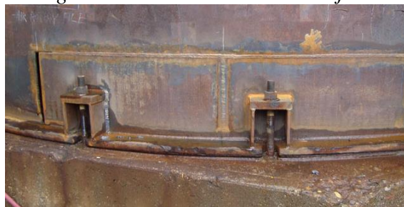
Figura N° 2.44: Pernos de anclaje
