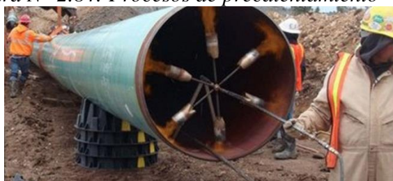
Figura N° 2.84: Procesos de pre calentamiento
