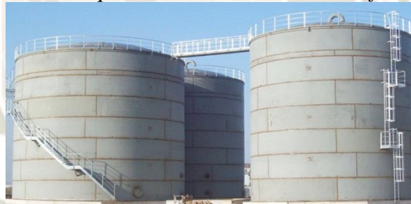
Figura N° 2.2 Tanques de almacenamiento atmosféricos
