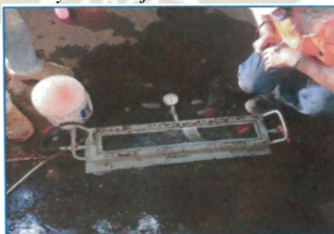
Figura N° 3.17: Ensayo con caja de Vacío en el Fondo del Tanque
