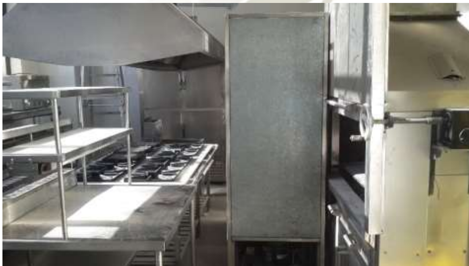
Figura 3. 44 :Equipos introducidos en cocina antes de cerrar tabiques.
