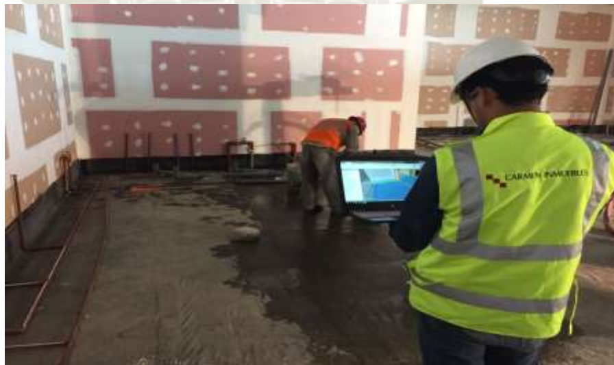
Figura 3. 22 : Liberación antes de un vaciado.
