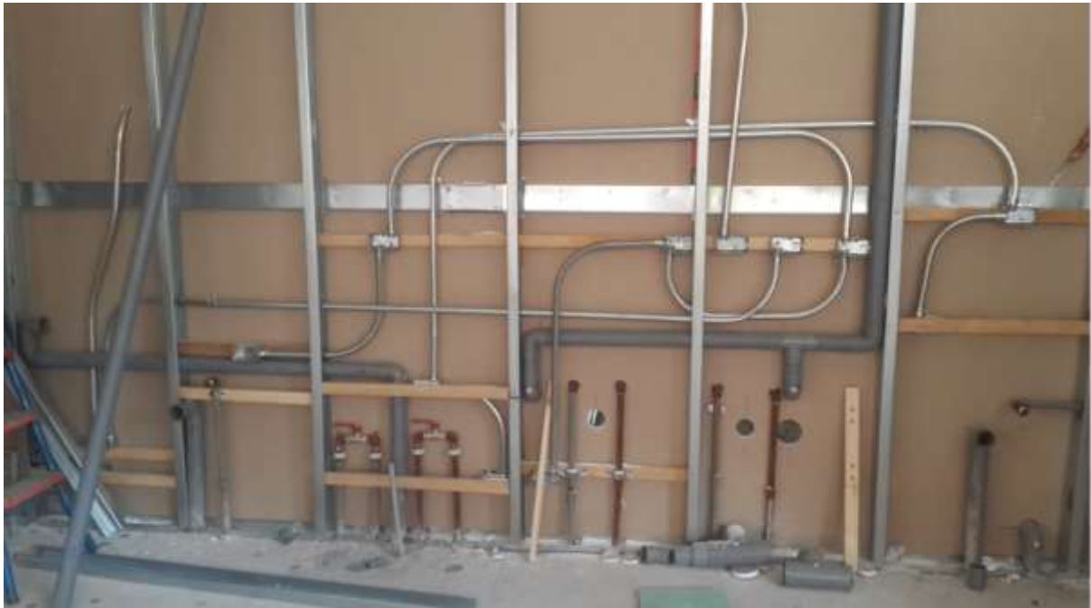
Figura 3. 58 : Vista de etapa en el tren de trabajo para la instalaciones en tabiquería
