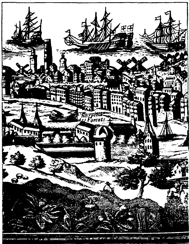
L'HÔPITAL DES FORÇATS A MARSEILLE
