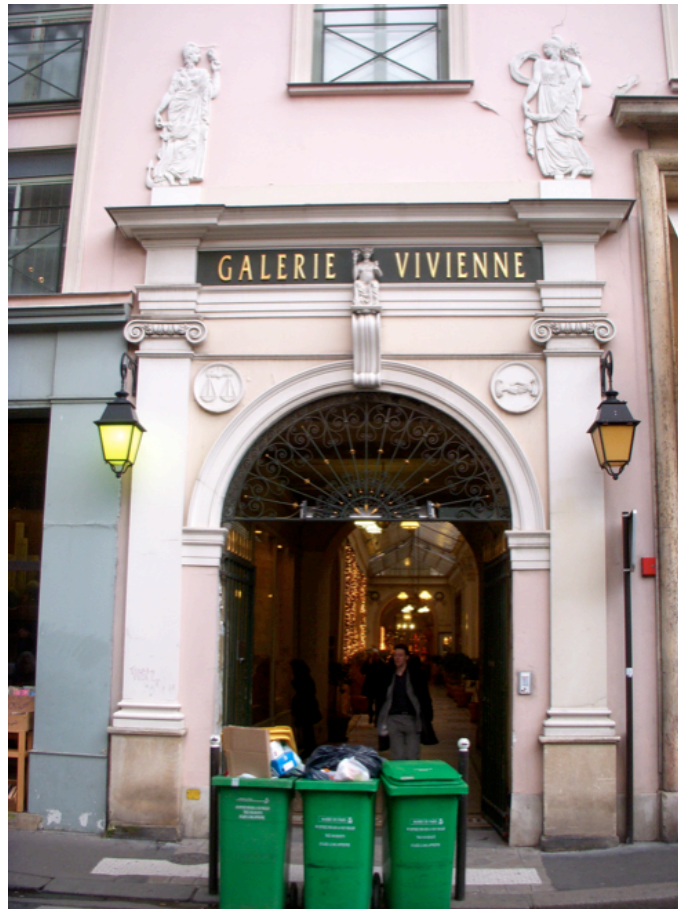
(Fig. 16) La Galerie Vivienne
