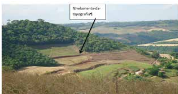
Figura 7 - Construção de nivelamento da topografia do relevo
