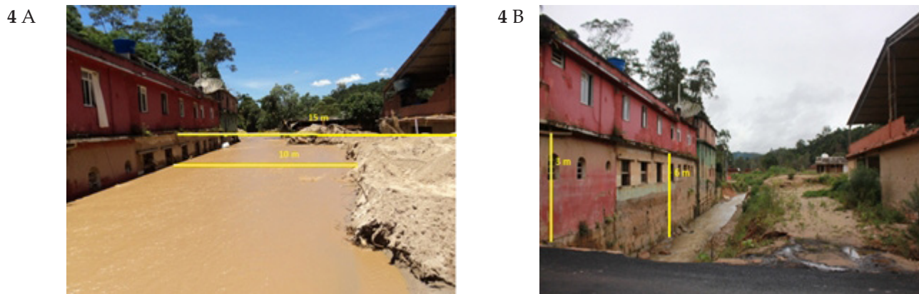
Figura 4: a) Inundação no terceiro ponto de estrangulamento no eixo principal de drenagem oito dias depois do evento; b) mesmo local em maio 2012.
