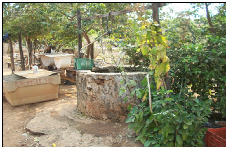
Figura 3 - Poço monitorado nº 10, sem proteção.
