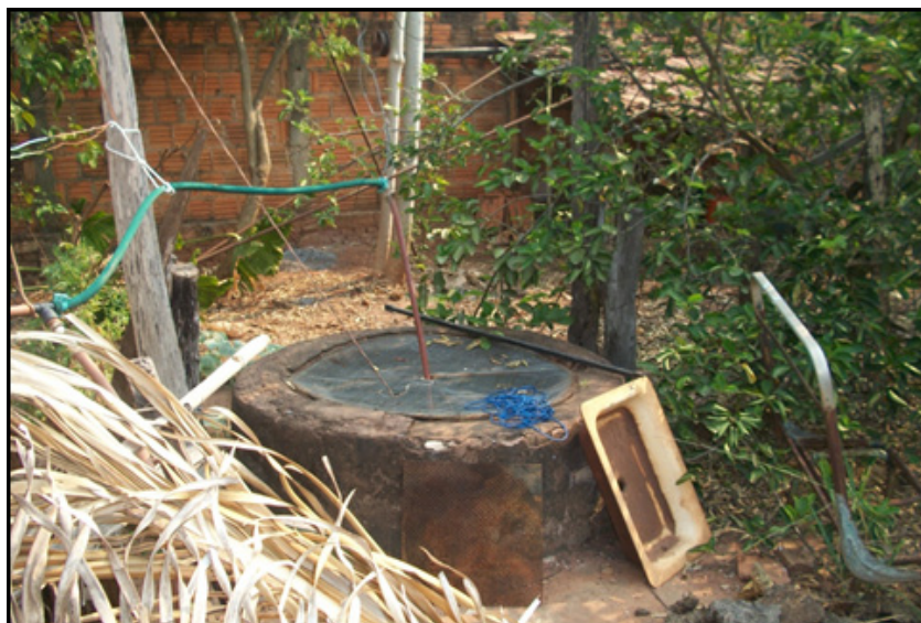
Figura 4 - Poço monitorado nº 06, com precária proteção e condições do entorno.
