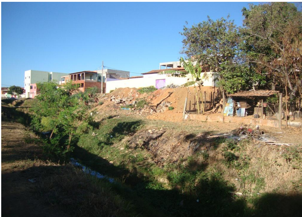
Figura 04 - Presença de construções no leito do rio Cintra e assoreamento.
