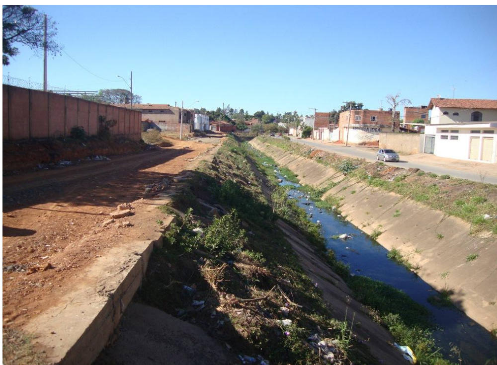
Figura 05 - Presença de material sólido nas vias sem pavimento.
