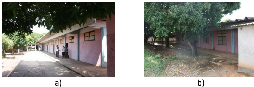
Figura 02 – Fachada principal (83°) da sala sem sombreamento (a) e fachada secundária (263°) da sala com sombreamento por Mangueira (b)
