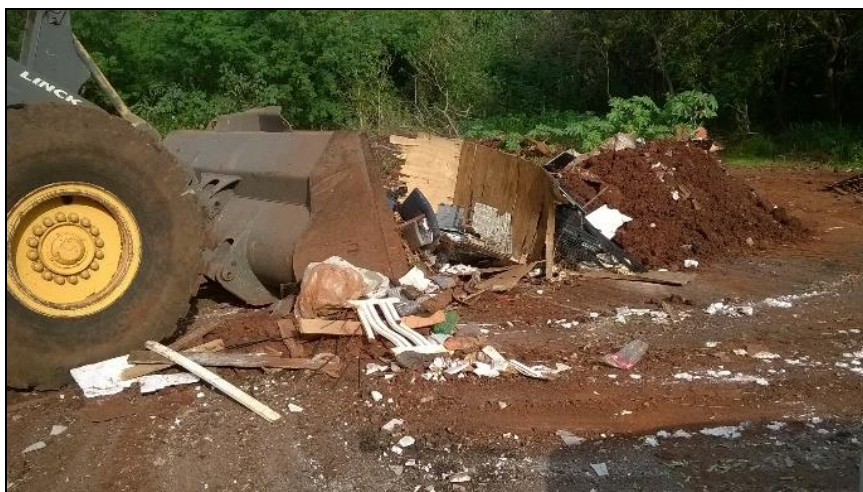
Figura 9 – Limpeza sendo realizada no ponto 2 Fonte: Autor, 2015.
