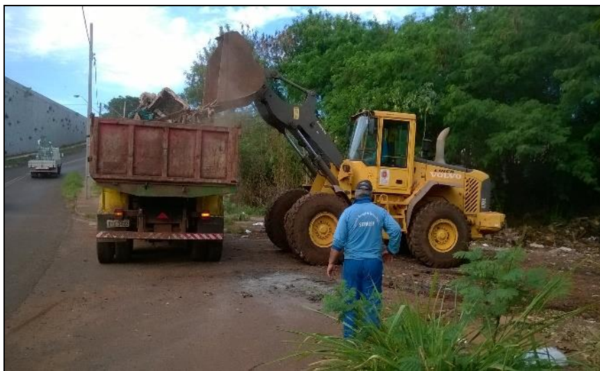
Figura 7 – Limpeza sendo realizada no ponto 1 Fonte: Autor, 2015.
