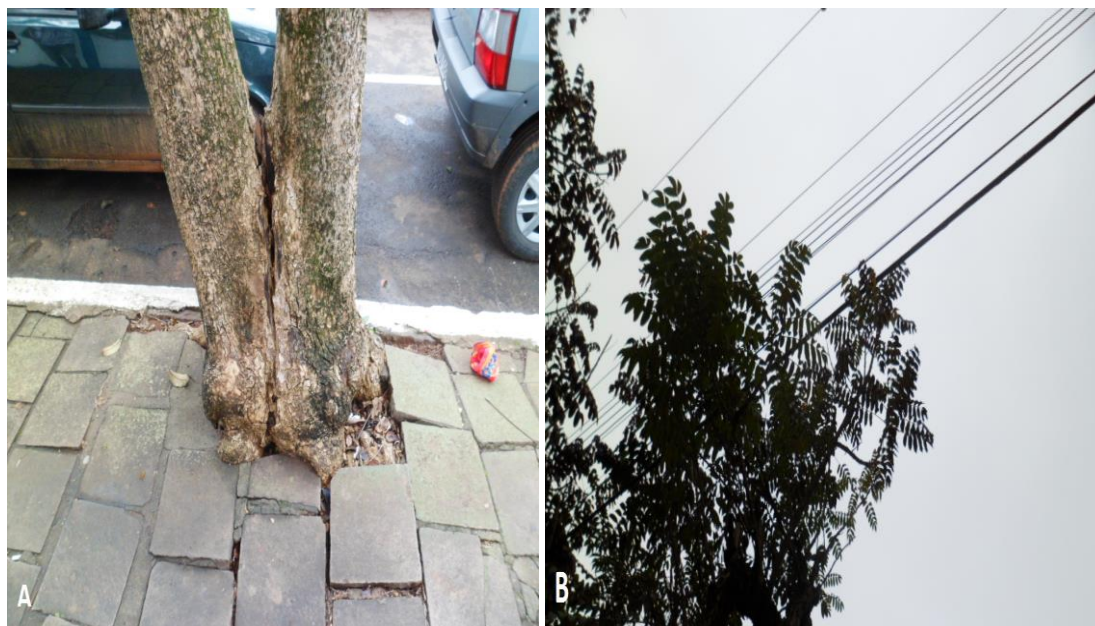
Figura 4 – (A e B) Árvore sem espaço livre para se desenvolver causando danos na calçada, poda irreparável, e indivíduo de grande porte tocando na fiação.
