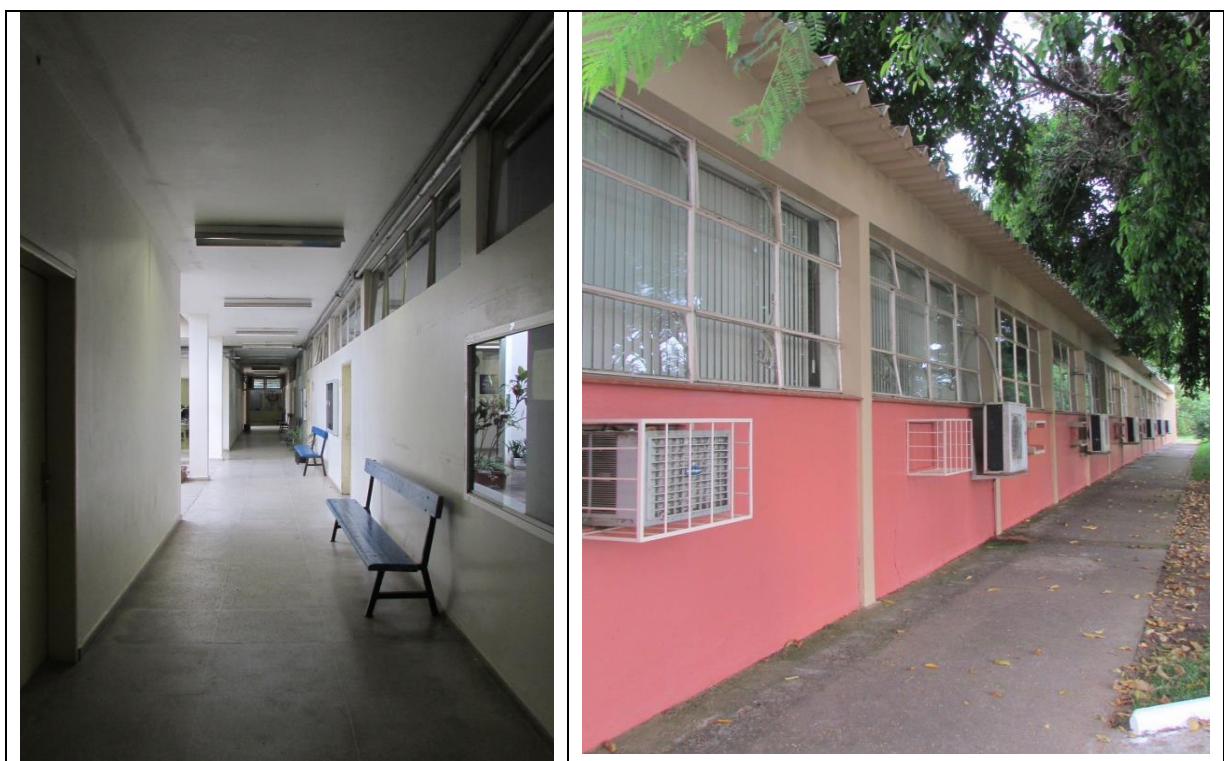
Figura 21 - Janelas voltadas para o corredor e para a área externa.
