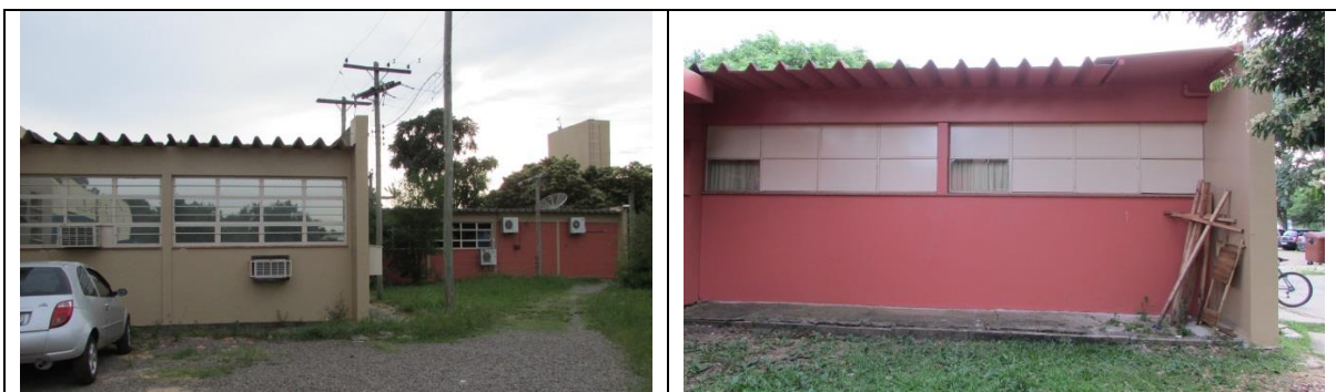
Figura 20 - Fachadas voltadas para o Oeste.
