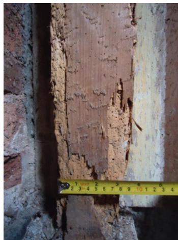
FIGURA 7: Pendural número 9 do Lado B, com degradação na base por insetos xilófagos.
