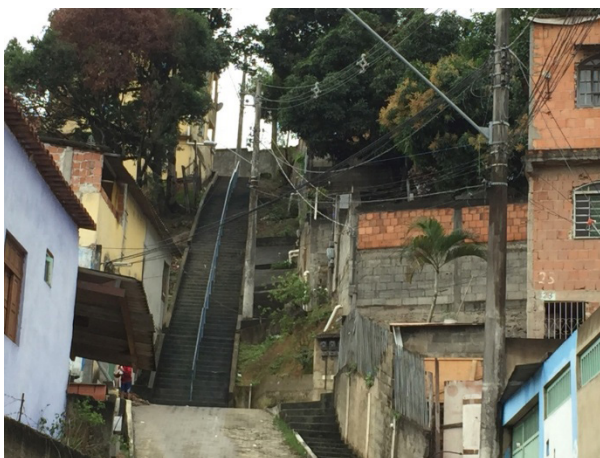
FIGURA 3: Residências construídas em locais com declividade superior a 45° no município de Serra-ES. FIGURE 3: Residences built in places with slope higher than 45° in Serra – ES state.
