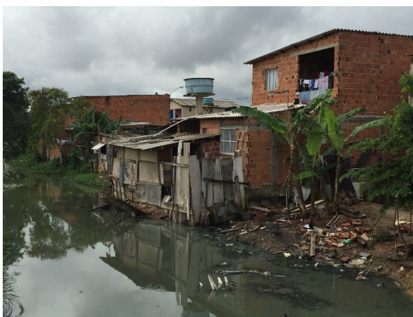
FIGURA 4: Invasão da calha regular do rio no município de Serra-ES. FIGURE 4: Invasion of the river bed in Serra – ES state.
