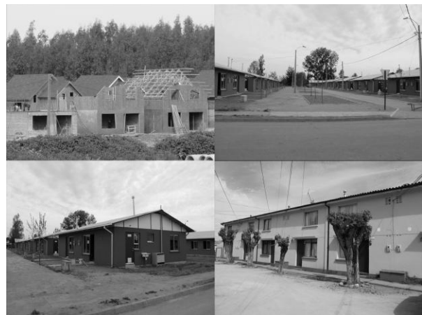
Figura 1: Viviendas de Reconstrucción en la Zona (elaboración propia).
