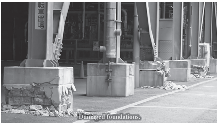
写真 4 H 形鋼の土台の粉砕
