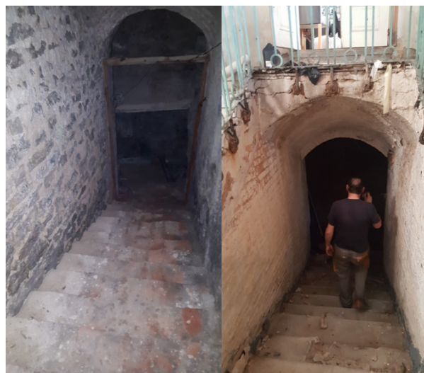
Figura 12. Izquierda y derecha, accesos a los manantiales de Baños Viejos (ref. 2517/3/0001) y Baños Nuevos (ref. 2517/3/0002).
