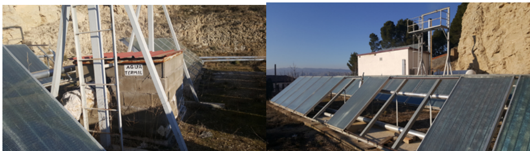
Figura 13. Situación del sondeo nuevo construido junto a los yesos aflorantes; y deposito adonde se transportan las aguas para su distribución posterior.
