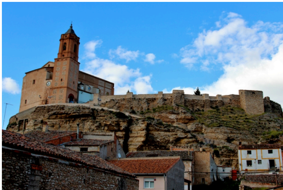
Figura 7. Vista de la parte alta de la población de Paracuellos de Jiloca construida en los contrafuertes rocosos de la zona, de naturaleza calcárea.
