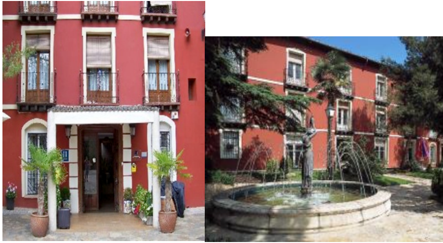
Figura 1. Vistas de la puerta principal de acceso (izquierda) y de la fachada y jardín anterior (derecha). Balneario de Paracuellos de Jiloca (Zaragoza).
