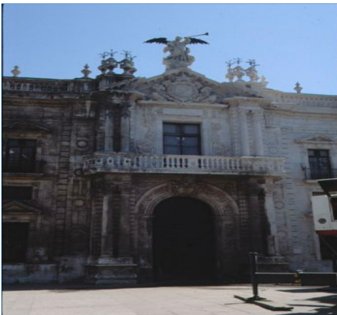
Figura 4.- Fachada del Rectorado de la Universidad de Sevilla durante su primera limpieza mecánica hace unos 25 años. Con posterioridad se han efectuado nuevas limpiezas en los últimos años.
