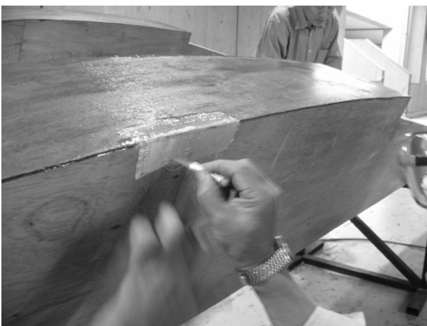
図9 外板合わせ部のFRP補強
