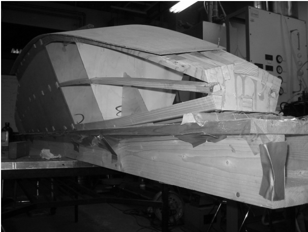
図7 外板の接着作業
