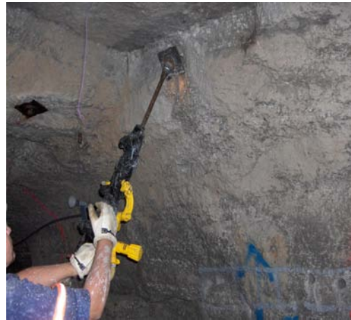
d. Installing a Rockbolt.
