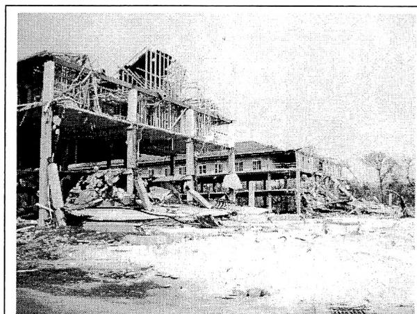
写真1 沿岸のコンクリート建物の全壊(ピロクシ)
