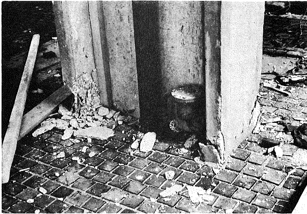
Fig. 17 Column Base (AISI)
