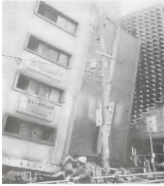
Şekil 2.3: 1995 Kobe depreminde bir binanın göçmesi
