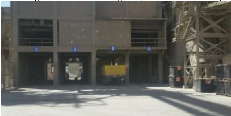
Figura 126. Zona de Carga Fajas – Ensacadora Antigua
