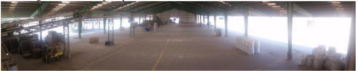
Fuente: Imagen tomada en planta una vez implementada la mejora
