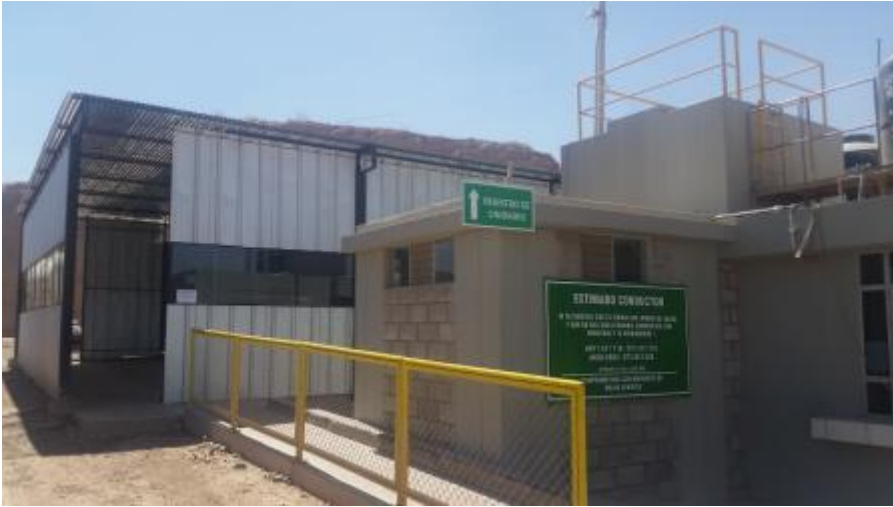
Fuente: Imagen tomada en planta una vez implementada la mejora
