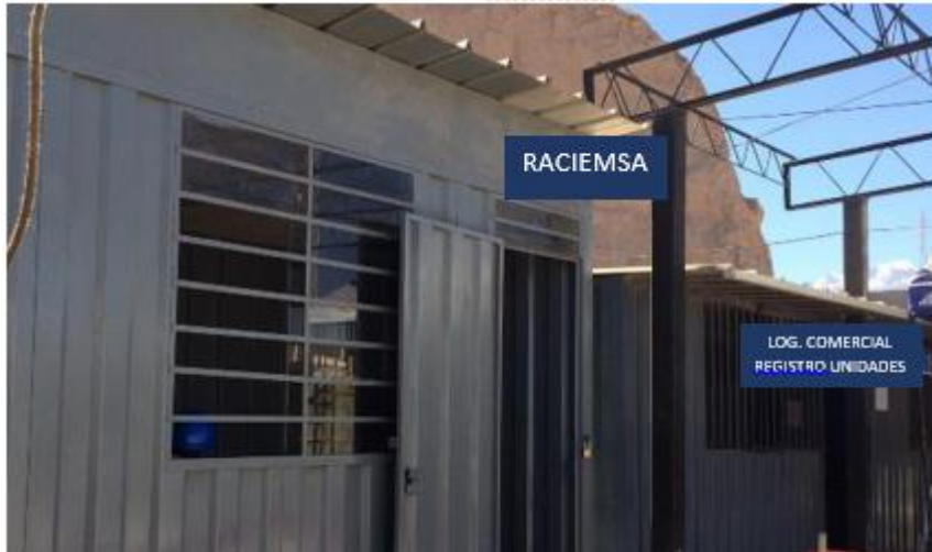
Fuente: Montaje propio sobre imagen tomada dentro de planta
