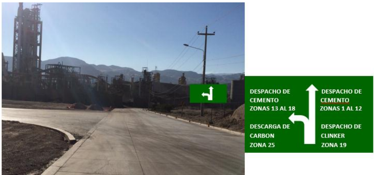
Fuente: Montaje propio sobre imagen tomada dentro de planta
