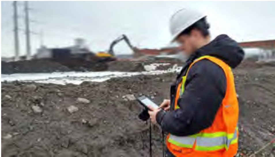
Figure 3.7 Utilisation des tablettes sur les chantiers du partenaire industriel
