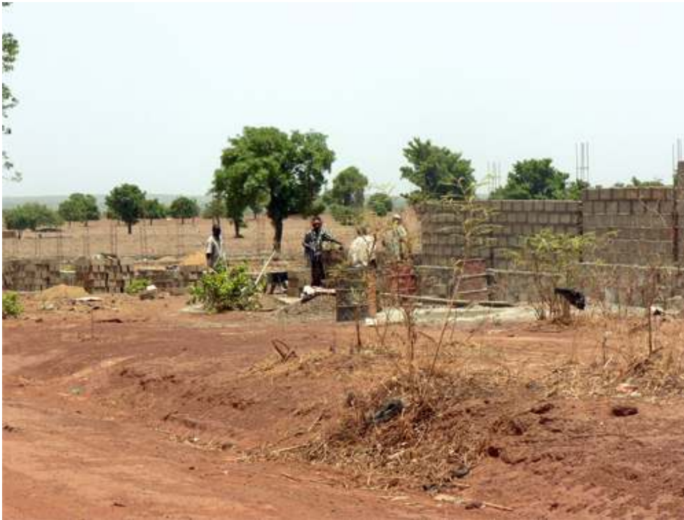
Figure 3 - Construction d'un muret en parpaing à Saala, dans la commune de N'Gbakoro Droit
