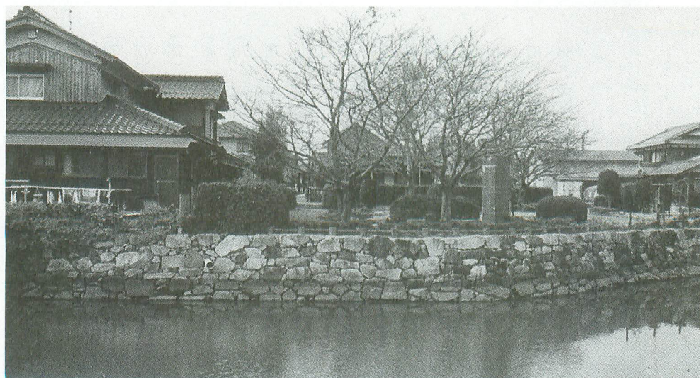
正面の石垣の地は、安土・神学校の跡地と推定されている。 石垣の下層は、信長の時代のもと考えられている。[筆者撮影]
