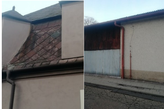
Obrázek 2 :Střešní konstrukce, dešťové svody [foto: Gillová, 2018]
