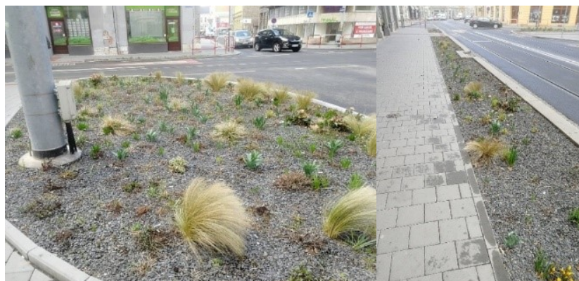
Obrázek 34: Vsakovací rýha [foto: Gillová, 2019]
