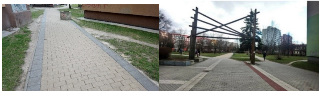
Obrázek 31: Betonová dlažba s drenážními spárami – Ostrava Dubina [foto: Gillová, 2019]
