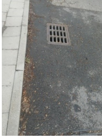
Obrázek 3: Vozovka s kanalizační vpustí [foto: Gillová, 2018]
