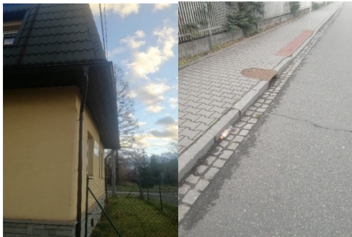
Obrázek 1: Střešní krytina s dešťovým svodem, Komunikace s dešťovým odtokem [foto: Gillová, 2018]
