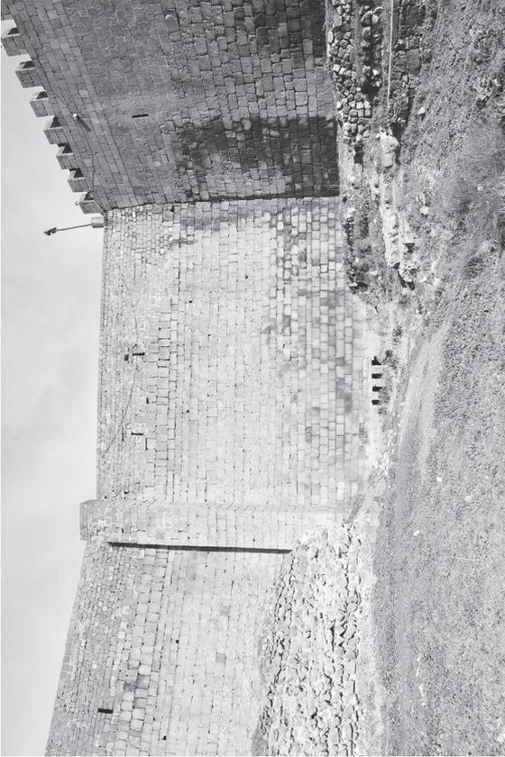
**Fig. 4 : Vue du collecteur dans son environnement. On distingue à gauche l'avant-mur et à droite le départ de l'aqueduc réaménagé à l'époque ottomane.**
