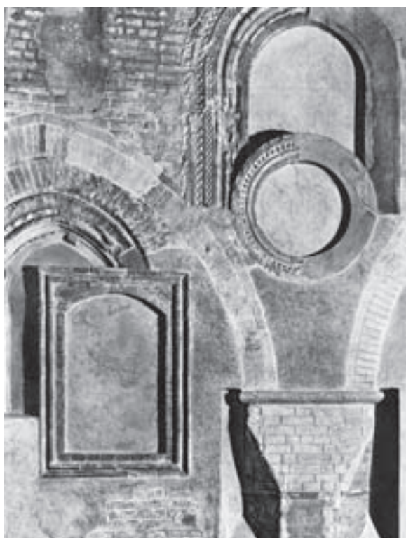
Fig. 5. Torino, Palazzo Madama, Galleria settentrionale del cortile: tracce delle sovrapposizioni di pareti e finestre nelle varie trasformazioni del palazzo al tempo degli Acaia (da Luigi Mallé, Palazzo Madama di Torino , I, Torino, Tipografia Torinese Editrice, 1970, p. 53).
