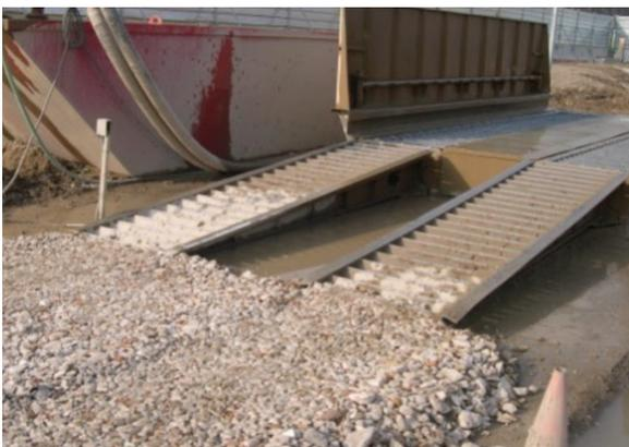
Figura 4 - Area di lavaggio delle gomme dei mezzi di cantiere prima della fuoriuscita su strada
