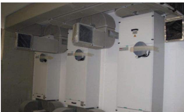
La protezione dalla polvere e da inquinanti gassosi può avvenire attraverso una sigillatura con plastica dei canali, delle bocchette di immissione ed estrazione dell'aria durante tutte le fasi di cantiere, dalla consegna all'installazione e messa in servizio.
